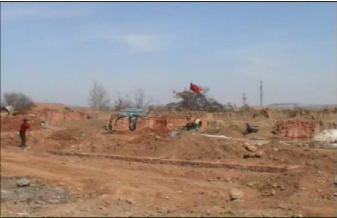
加油站施工现场
