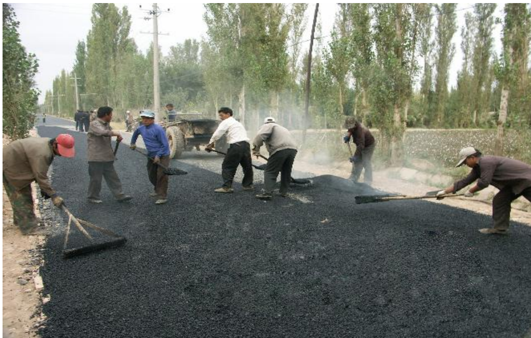
公路施工现场
