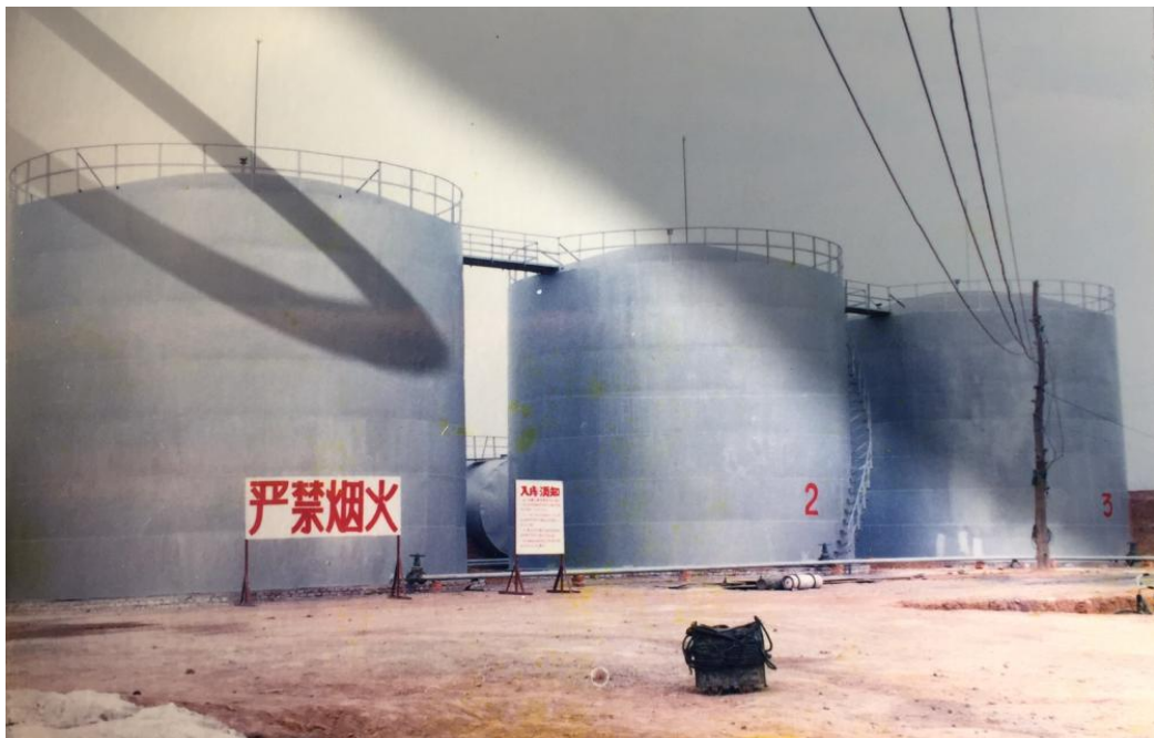
振东第二座油库实景
