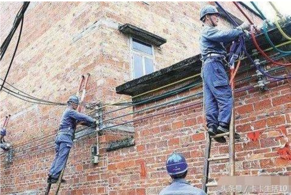
电网改造现场
