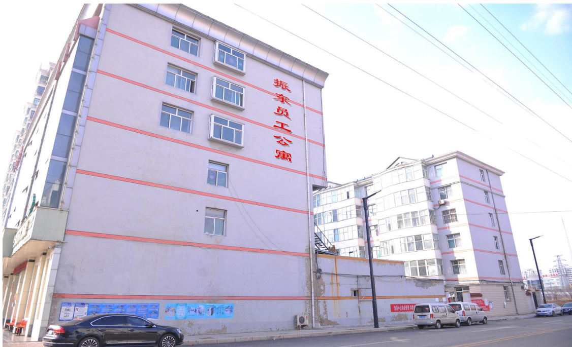
一期振东公寓实景
