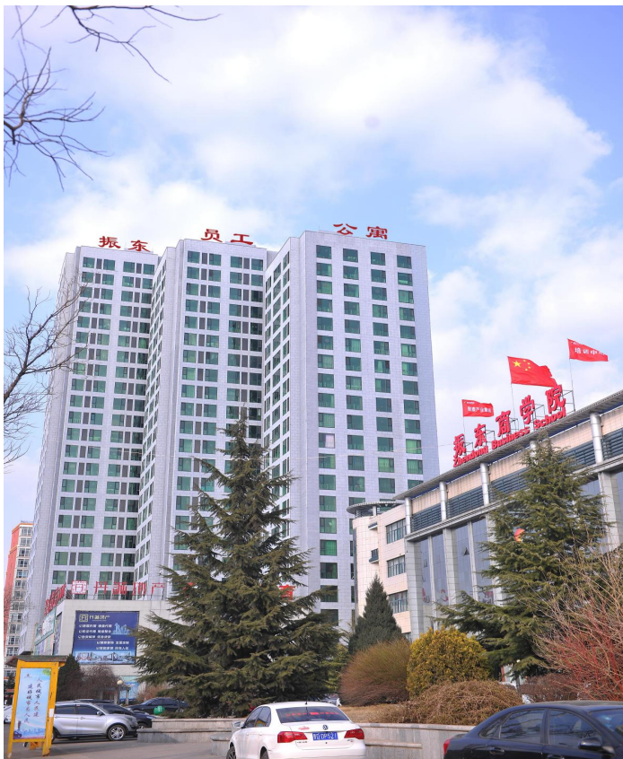
振东二期员工公寓实景
